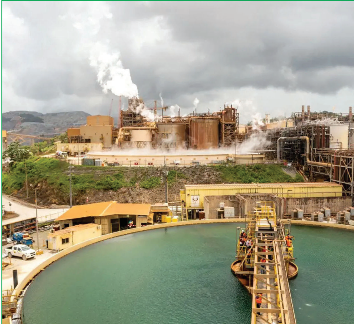
Una presa de colas o un depósito de relaves es un lugar donde se depositan los materiales inertes del proceso minero, que previamente han sido neutralizados.
