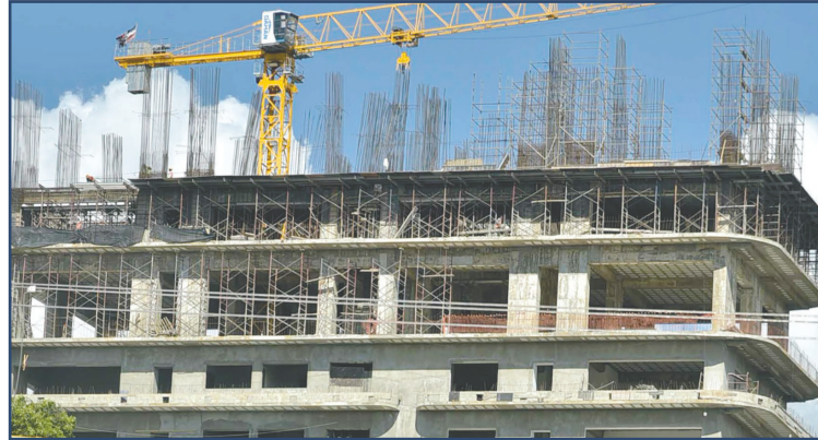
La condición del suelo obliga a los ingenieros a utilizar criterios constructivos distintos a los que son aplicados en partes rocosas.
